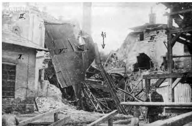
6. ábra. A beomlott Sopron-akna
