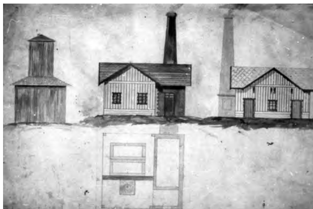
2. ábra. 1836: az első olyan gőzgép Magyarországon, amely szénbányában működött
